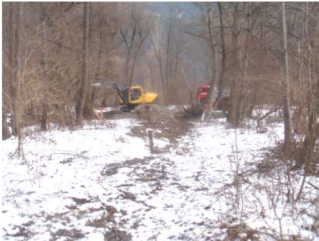
Bild 1: Beginn der Renaturierungsarbeiten in der Innau bei Telfs Quelle: Mag. Traute Scheiber, ITS Scheiber
